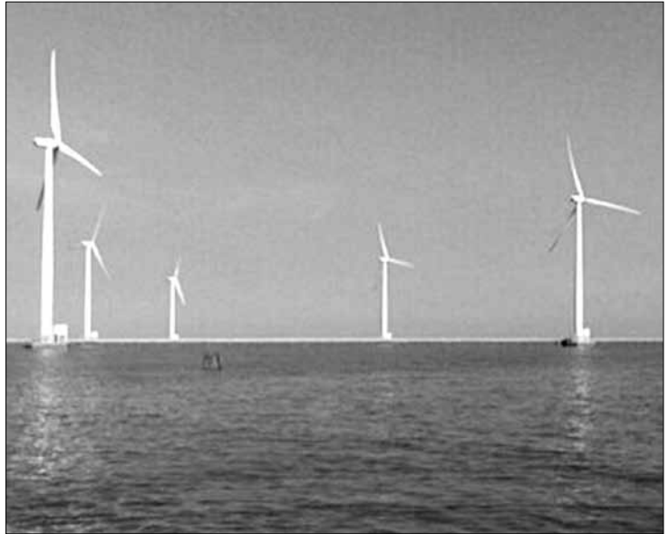
▲ Nhà máy điện gió Bạc Liêu tạo ra năng lượng sạch, góp phần phát triển bền vững đất nước
